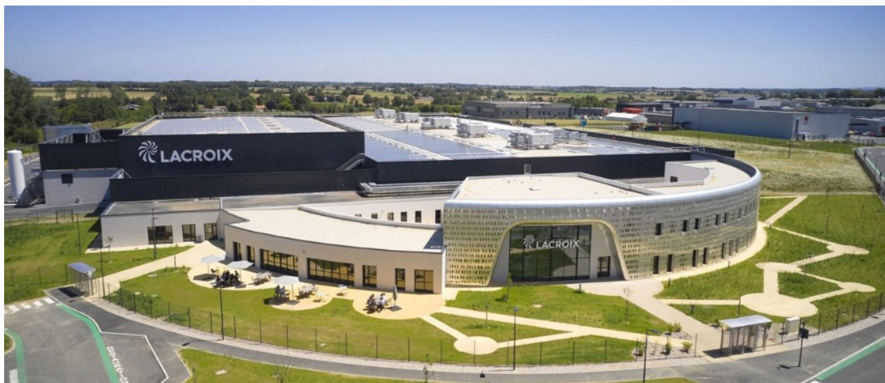
Figure 1 : Le nouveau bâtiment récemment inauguré (source : groupe Lacroix).
