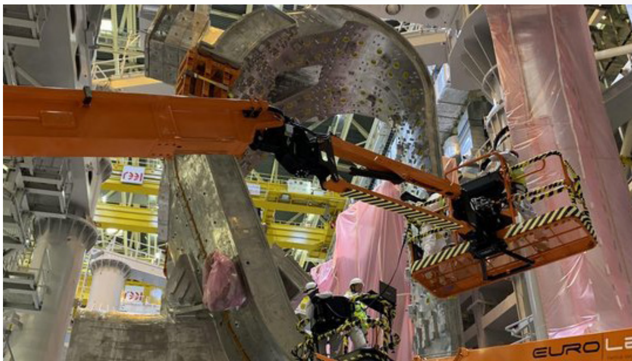
Figure 2 : Le montage du réacteur ITER se poursuit activement – Crédit photo : Juliette Raynal/La Tribune.
