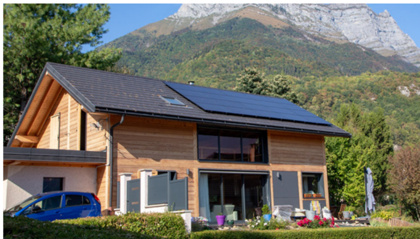
Figure 1 : Maison témoin avec ses 20 panneaux de 280 Wc installés fin 2018.
