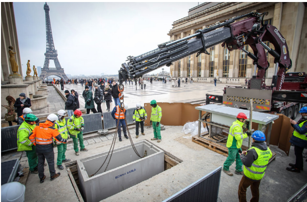
Figure 1 : Travaux Enedis au Trocadéro – source Enedis.
