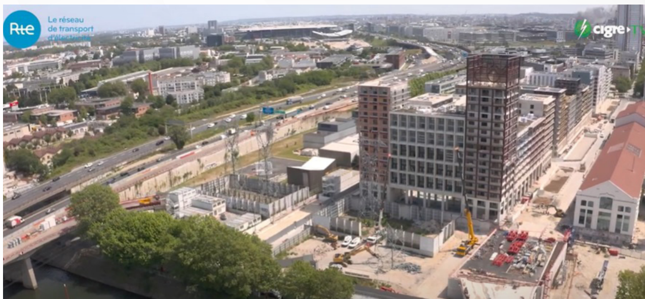
Figure 3 : Espace libéré par RTE en Seine Saint Denis – source RTE.
