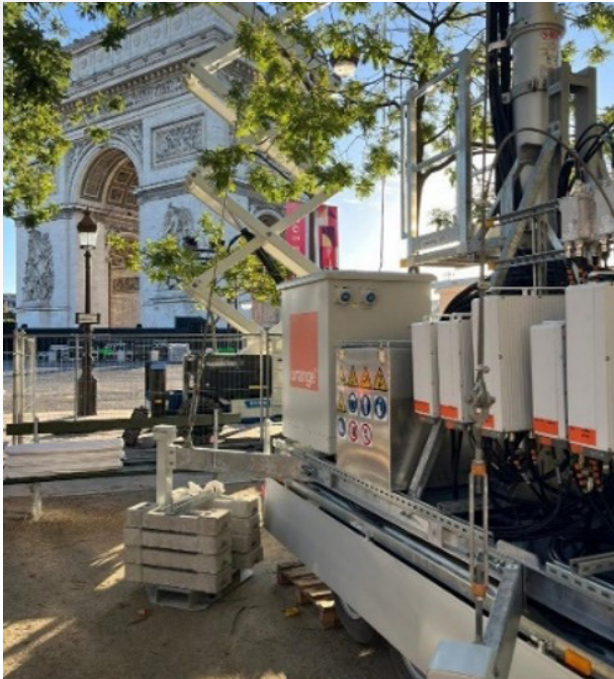
Figure 1 : Complément de couverture près de l'Arc de Triomphe.
