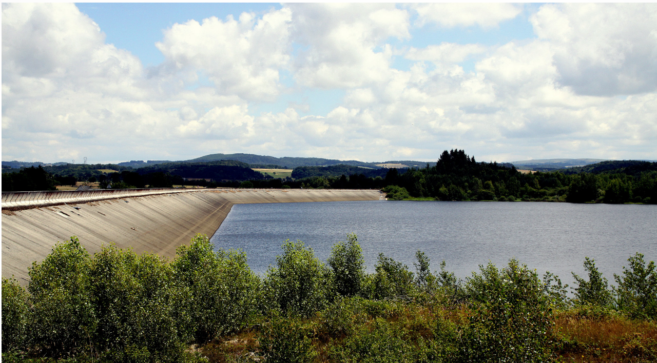
Figure 1 : Le barrage de Monnès, formant le réservoir supérieur de la centrale de pompage-turbinage de Montézic (Aveyron), mise en service en 1982.
