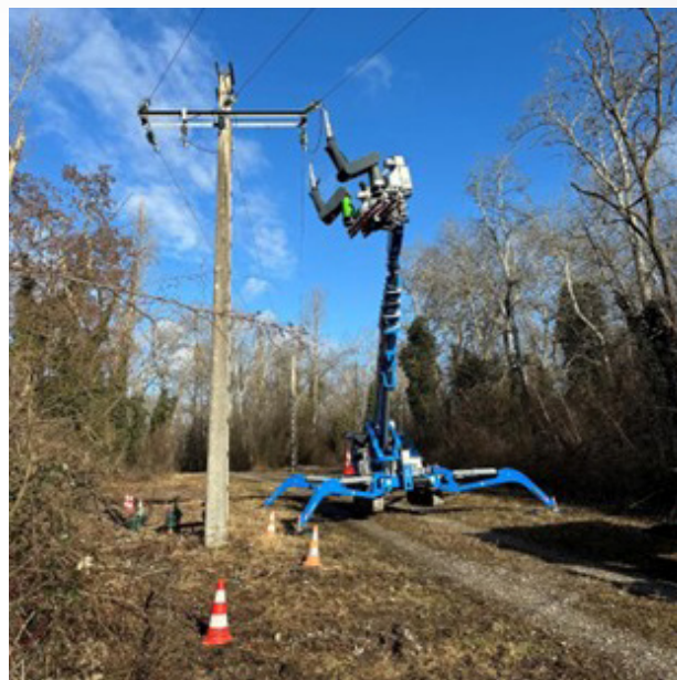
■ Figure 1 : Réalisation d'un pontage » par TST-Bot sur un réseau 20 000 V.
