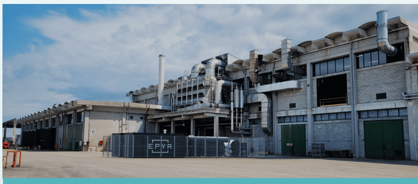
Figure 2 : L'unité Epyr sur le site de Wepa à Troyes.
