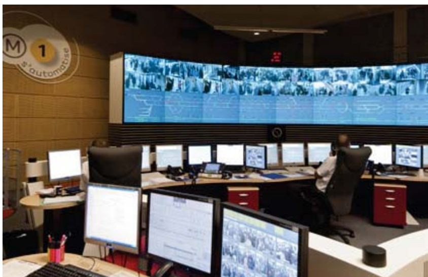
Photo 1 : PCC RATP de la ligne 1 du métro de Paris.
