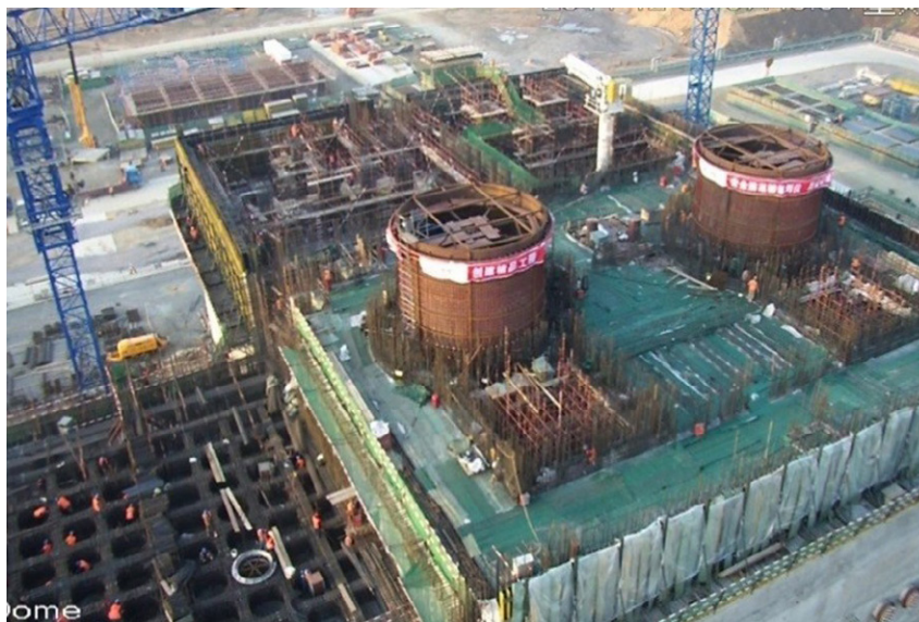
Figure 5 : Vue des deux HTR chinois de 100 MWe en cours de construction.
