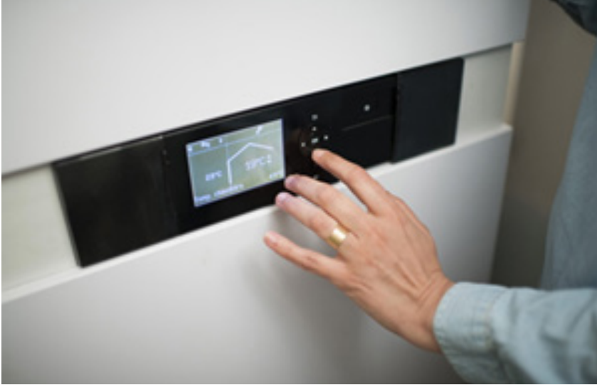
Figure 9 : Interface de pilotage d'une PAC.
