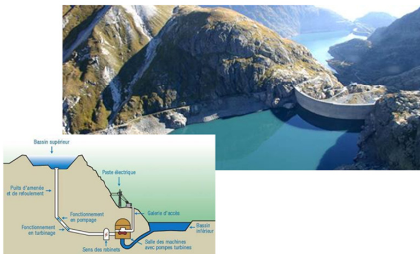
■ Station de transfert d'énergie par pompage (STEP) de Nant de Drance (Suisse).
